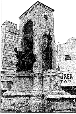
Taksim Cumhuriyet Anıtı'nın, su akıtma ağız ve yalağının bulunduğu cepheden görünüşü - Taksim / İstanbul
